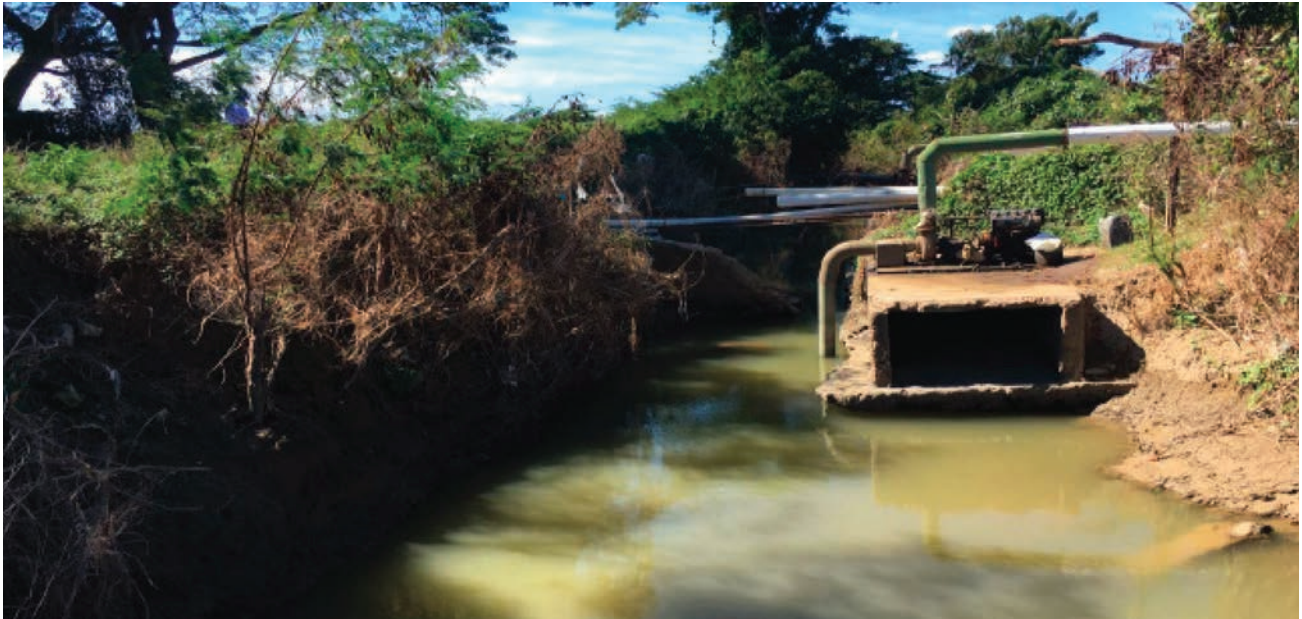
Construcción de un puente colgante y una canaleta metálica en un canal en el sector Juliana Jaramillo
